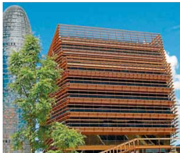
Edifici del 22@ de Barcelona on hi ha la seu de la Comissió del Mercat de les Telecomunicacions ■ EL PUNT AVUI
