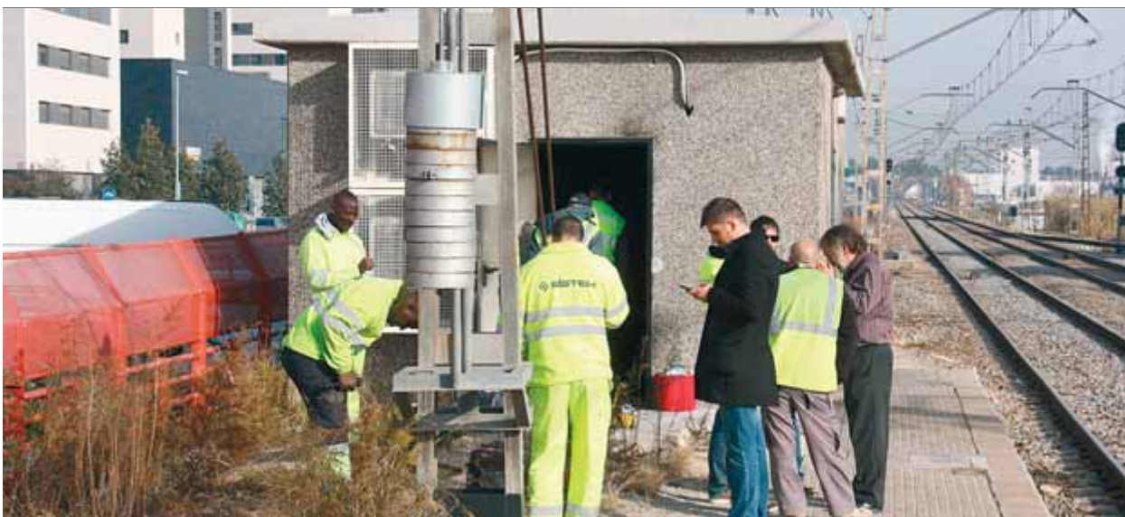
La cabina d'instal·lacions de seguretat que es va incendiar a prop de Mollet-Sant Fost el 15 de desembre passat ■ ACN
