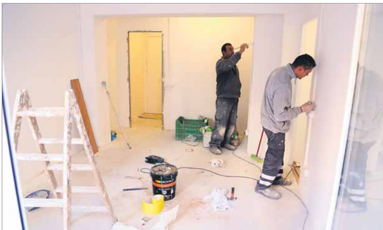
Rehabilitació de pisos al barri d'Horta de Barcelona per a lloguer social de la Taula del Tercer Sector ■ JUANMA RAMOS / ARXIU
