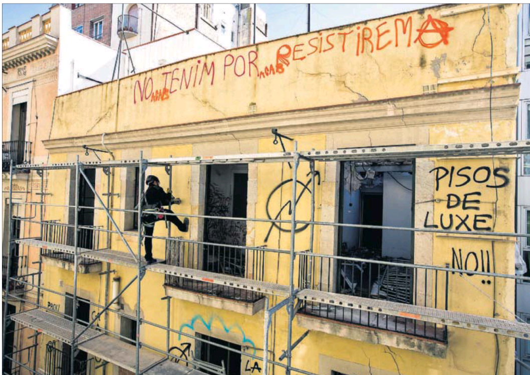
Los trabajadores colocan diversos andamios en la casa okupa de Barcelona Ca la Trava, que será derribada. / JOAN SÁNCHEZ
